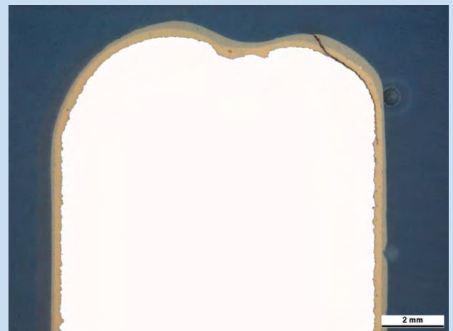
Abb. 5: Abgerundete Kante mit beginnender Korrosion (links). Ursache ist die Rissbildung in der Beschichtung (rechts).
